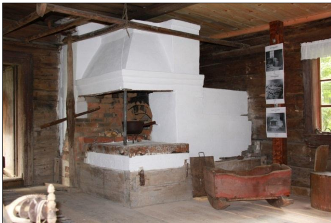
Eldstäderna har 2012 fått en ny kalkputsyta Tulisijat ovat 2012 saaneet uuden kalkkilaastipinnan
