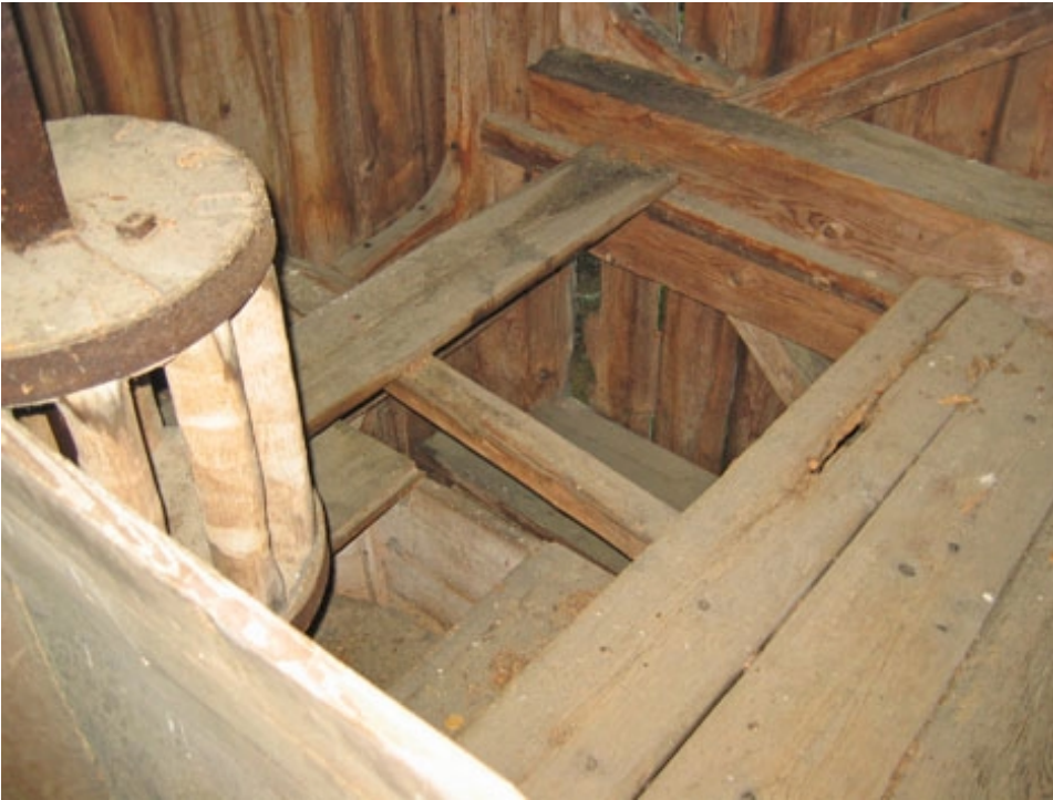
Hinkabölen tuulimyllyn 2. kerroksen ratashuoneen hammasrattaan vastakappaleen pyöritysakseli ja pystykapulat, kuvaus 2006-11-18 (PHo)
