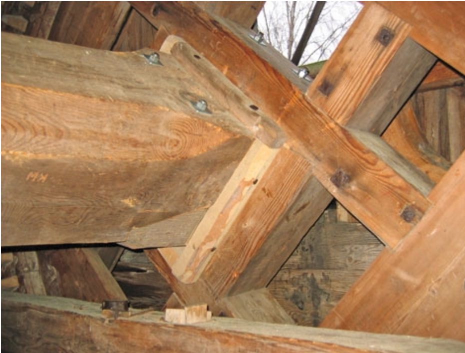
Hinkabölen tuulimyllyn 2. kerroksen ratashuoneen siipilapojen akseli, kuvaus 2006-11-18 (PHo)
