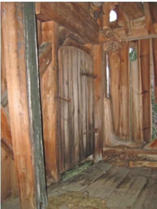
Hinkabölen tuulimyllyn 2. kerroksen ratashuoneen ulko-ovi, kuvaus 2006-11-18 (PHo)
