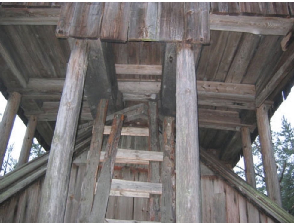
Hinkabölen tuulimyllyn alusta ja varpaitten yläpää, kuvaus 2006-11-18 (PHo)
