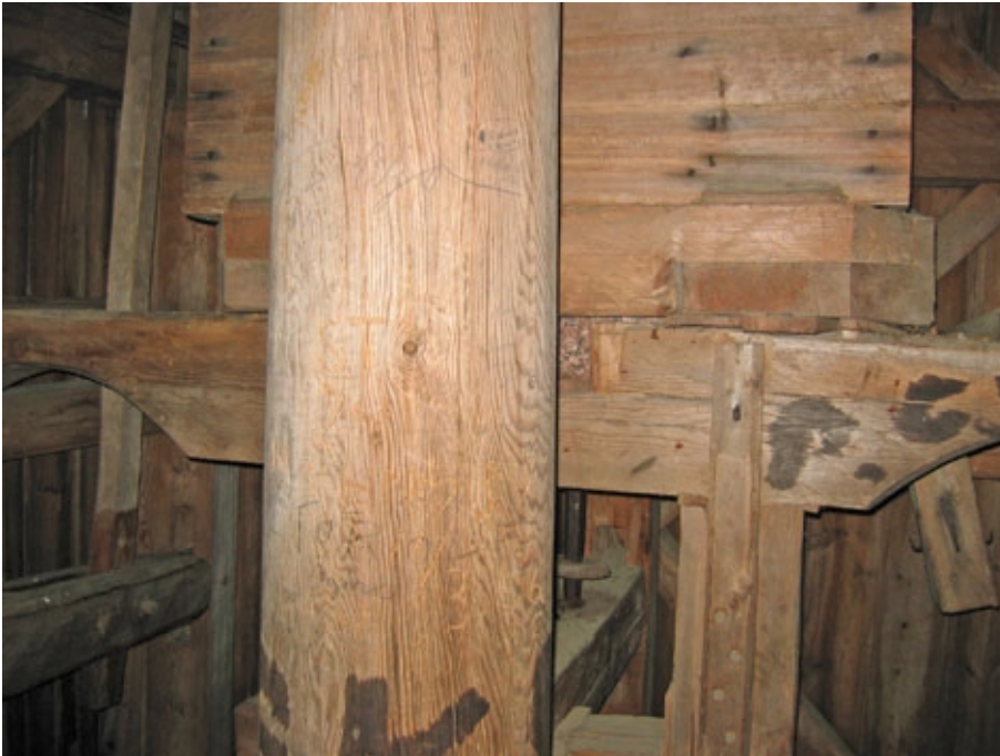
Hinkabölen tuulimyllyn 1. kerroksen napa ja jauhinkiviarkku takana, kuvaus 2006-11-18 (PHo)
