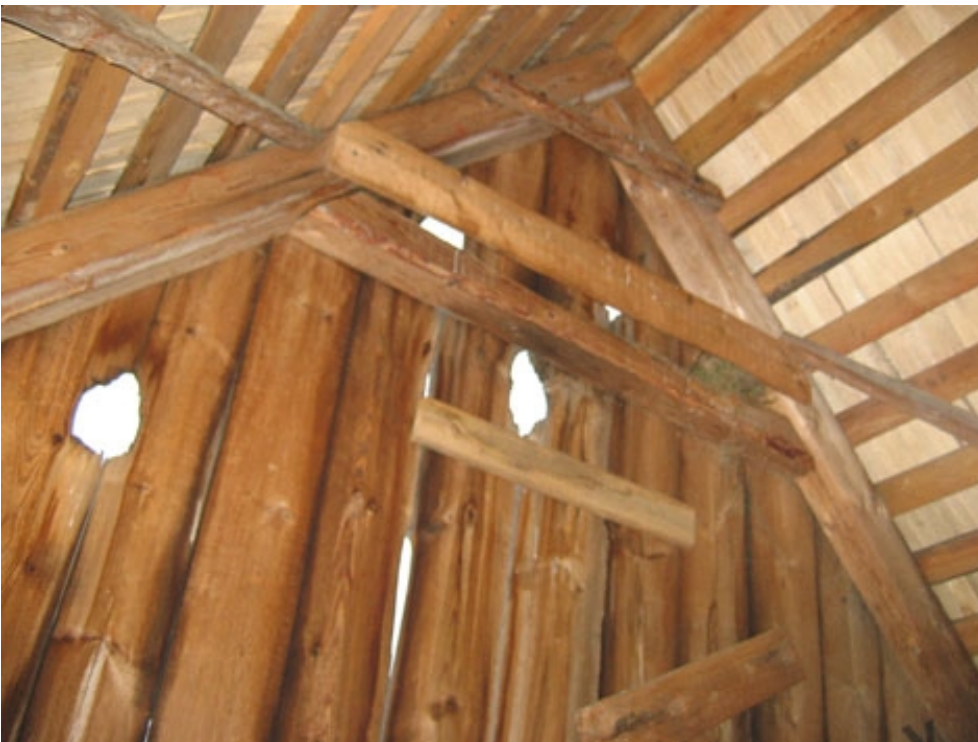
Hinkabölen tuulimyllyn 2. kerroksen ratashuoneen eteläpääty sekä vesikatto sisältä, huomaa tikan/palokärjen tekemät suuret reiät seinässä, kuvaus 2006-11-18 (PHo)
