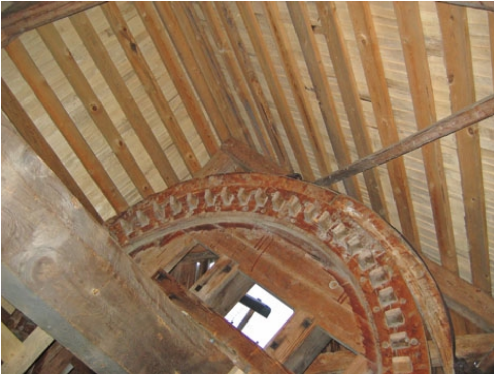
Hinkabölen tuulimyllyn 2. kerroksen ratashuoneen hammasratas ja hammasrattaan pyöritysakseli sekä vesikatto sisältä, kuvaus 2006-11-18 (PHo)
