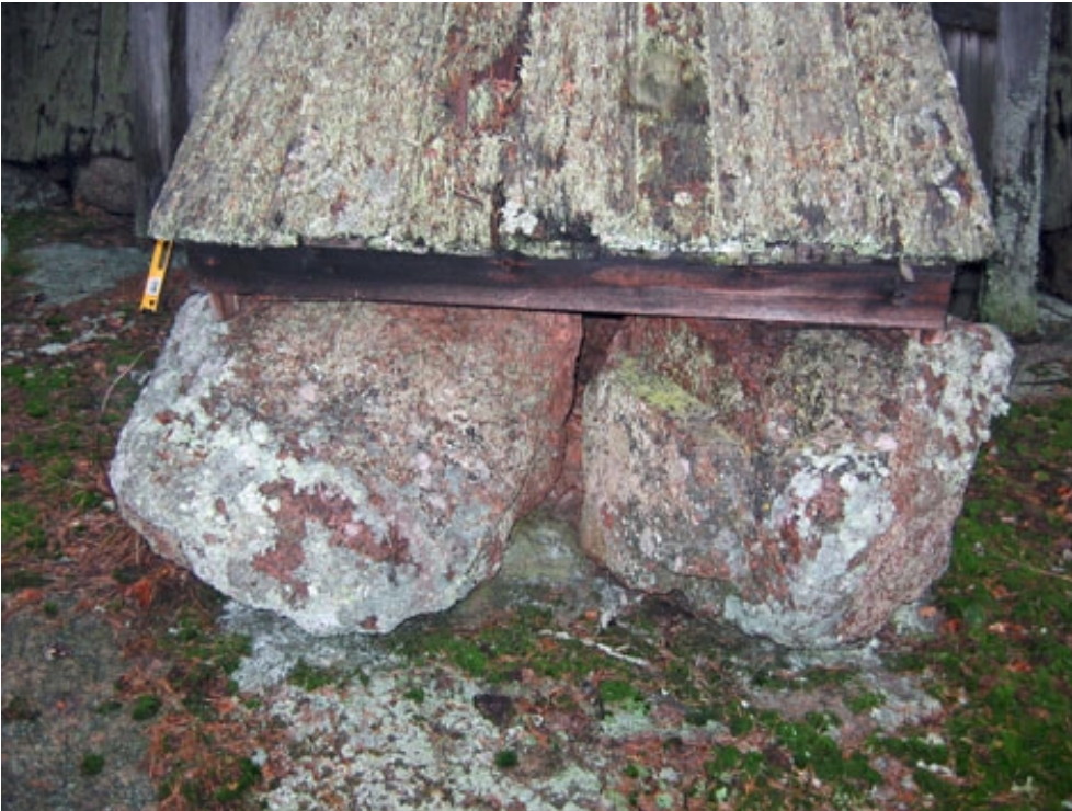
Hinkabölen tuulimylly ja sen jalustakivet kallion päällä, kuvaus 2006-11-18 (PHo)
