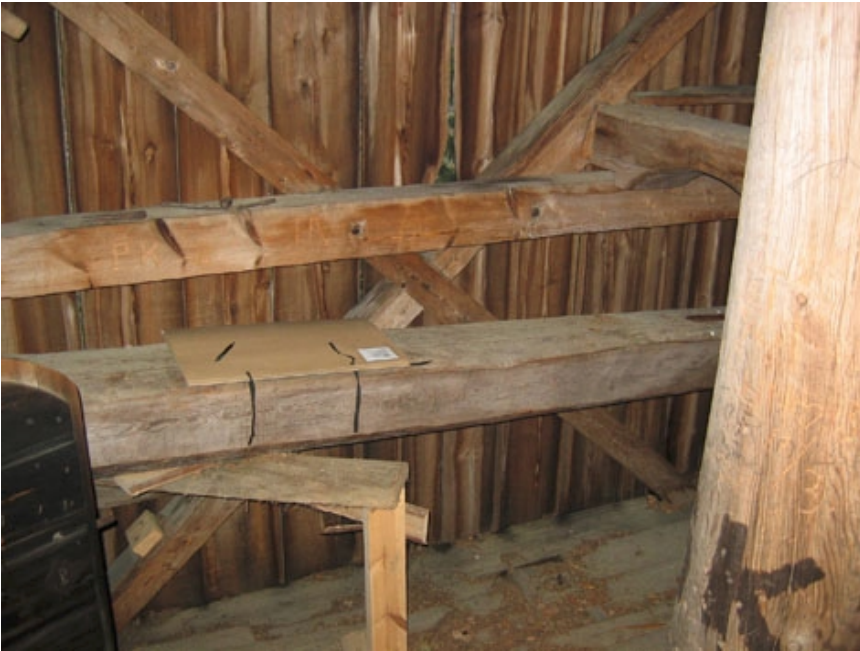
Hinkabölen tuulimyllyn jauhinkivihuoneen läntinen seinä ja jarrutangon ohjauspalkki, kuvaus 2006-11-04 (PHo)
