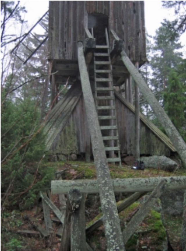
Hinkabölen tuulimylly ja sen jalusta ja sisäänkäynti etelästä, kuvaus 2006-11-18 (PHo)
