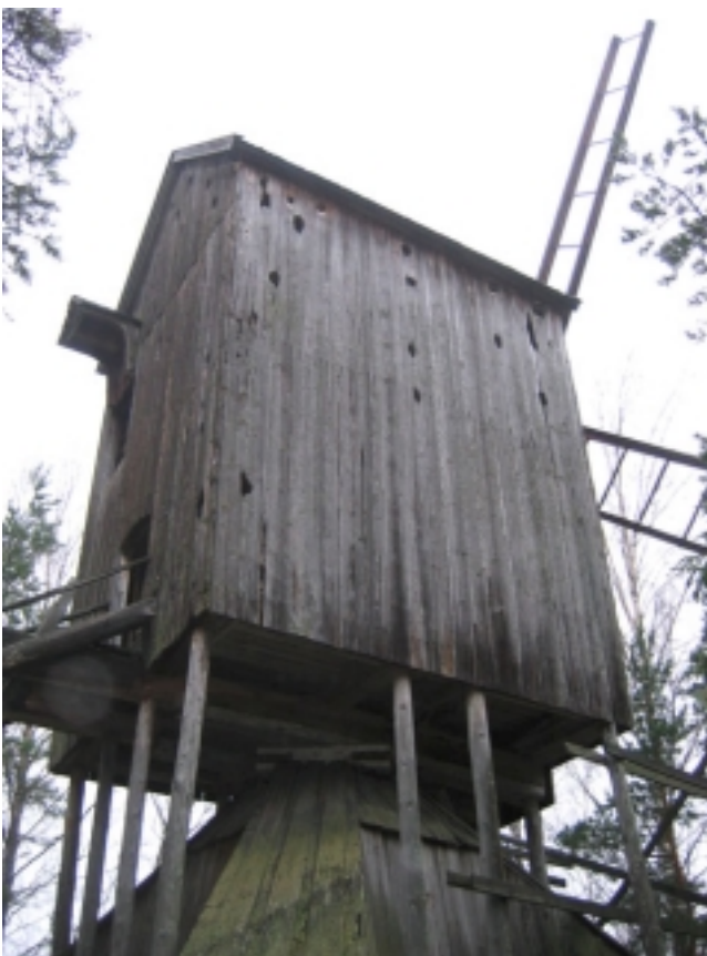
Hinkabölen tuulimylly ja sen jalusta idästä, huomaa tikän/palokärjen tekemät suuret reiät tuulimyllyn seinässä, kuvaus 2006-11-18 (PHo)
