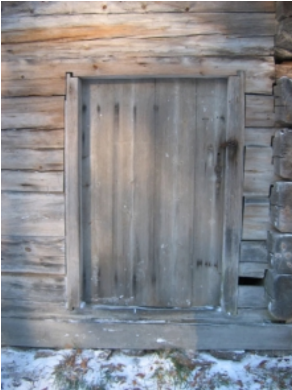
Hinkabölen tuparakennuksen ulko-ovi, pysty-laudoitettu ovi sisäpuolisilla ovirakenteeseen upotetuilla pienapuilla varustettu, kuvattu 2006-11-04 (PHo).
