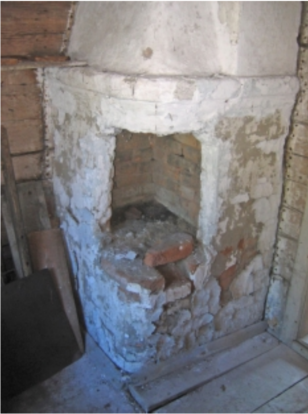
Hinkabölen tuparakennuksen tiilirakenteinen rapattu ja kalkkimaalattu nurkkauuni. Seinäpinnoissa näkyy nupinaulojen reikiä, joten kamari on ollut aikaisemmin pinkopahvitettu/ tapeetoitu. Kuvattu 2006-09-16 (PHo).
