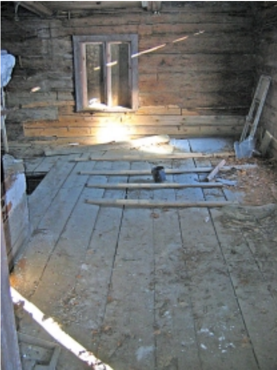
Hinkabölen tupa koillispäätä vasten. Tässä näkyy ikkunan allal hirsikertojen aikaisempi vaihto. Vasemmalla näkyvä aukko kellarin, kuopan lattia-aukko. Kuvattu 2006-11-04 (PHo).
