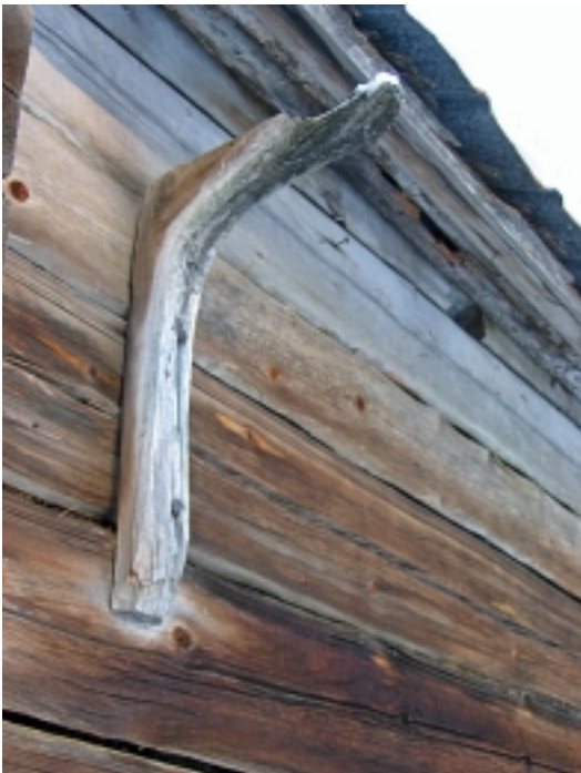
Hinkabölen tuparakennuksen puurakenteisen kattovesikourun kannatin, kuvattu 2006-11-04 (PHo).
