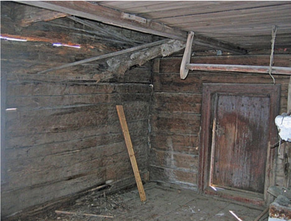
Hinkabölen tuvan kaakkoisen pitkän sivun ja oven viereistä vaurioitunutta hirsiseinä- ja yläpohjarakennetta. Vesikatto on suojattu tilapäisellä peltikatteella vuonna 1991. Kohde on kuvattu 2006-.11-04 (PHo)
