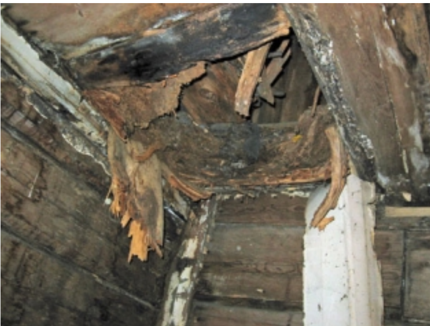
Hinkabölen tuparakennuksen eteiskamarin lahonnutta yläpohjaa tuvan vastaisella seinällä. Kuvattu 2006-11-04 (PHo).
