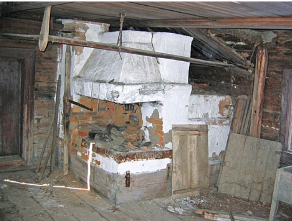
Hinkabölen tuvan liesi ja leivinuuni, joka lepää hirsiaarkun varassa vanhakarjalaiseen tapaan. Ota myös huomioon uuni peränurkan lahonnut välipohja. Oikealla olevan puuluukku on kellarin luukku. Vasemmanpuoleinen luukku/ovi voi olla päätyluhtiaitan puuttuva ulko-ovi. Tämä tulee vielä tarkistaa. Kuvattu 2006-11-04 (PHo)
