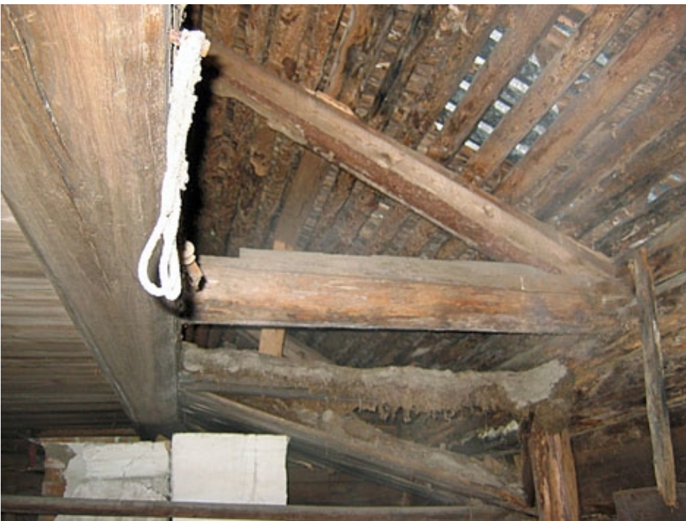
Hinkabölen tuvan uunin taustan ja rakennuksen luoteissivun lahonnutta välipohjaa. Ota huomioon kattotuolirakenne, joka on tässä esillä. Kuvattu 2006-11-04 (PHo).
