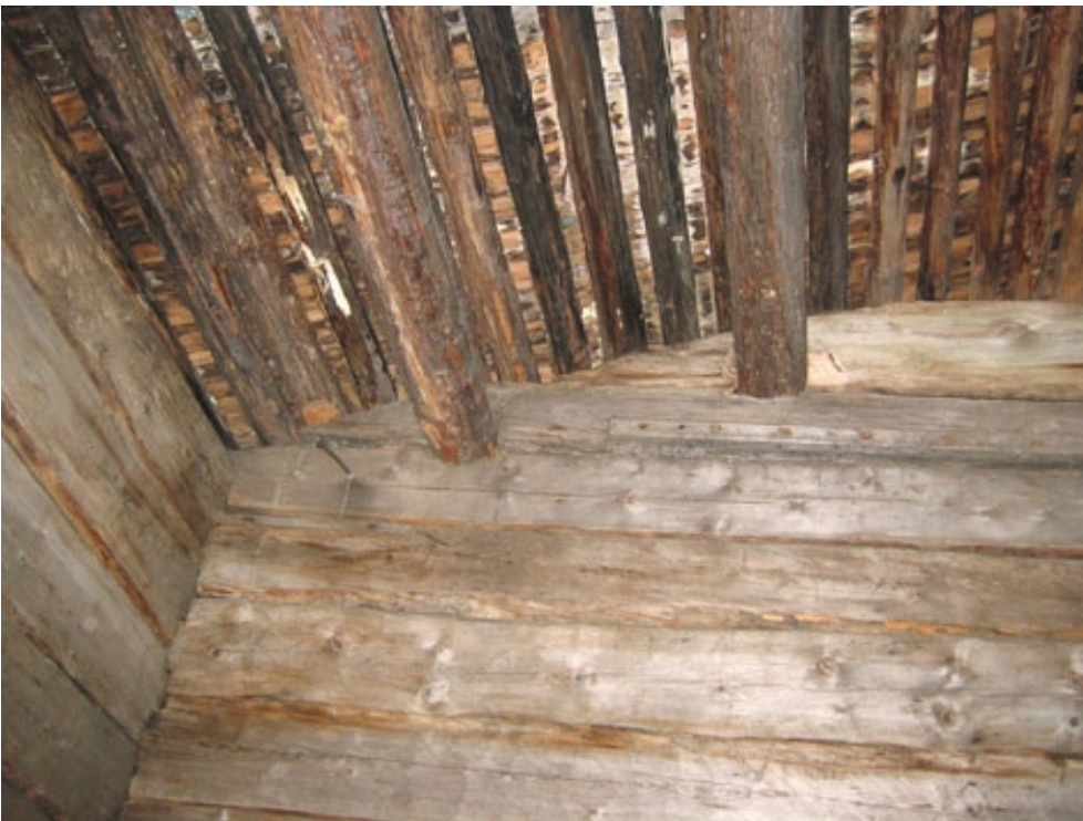
Hinkabölen luhtiaitan pohjoista päätyhirsiseinää ja vesikattorakennetta luoteisnurkassa, kuvaus 2006-11-18 (PHo).
