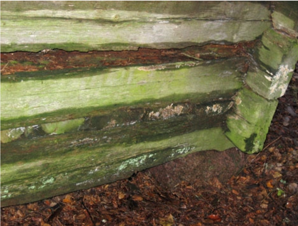
Hinkabölen luhtiaitta idän puoleinen sivu, jossa näkyy pahoja lahovaurioita hirsikerroissa pistolattian sekä seinän kohdalla. Huomioon on myös otettava sammal-, levä- ja jäkälämuodostumat, kuvaus 2006-11-18 (PHo).
