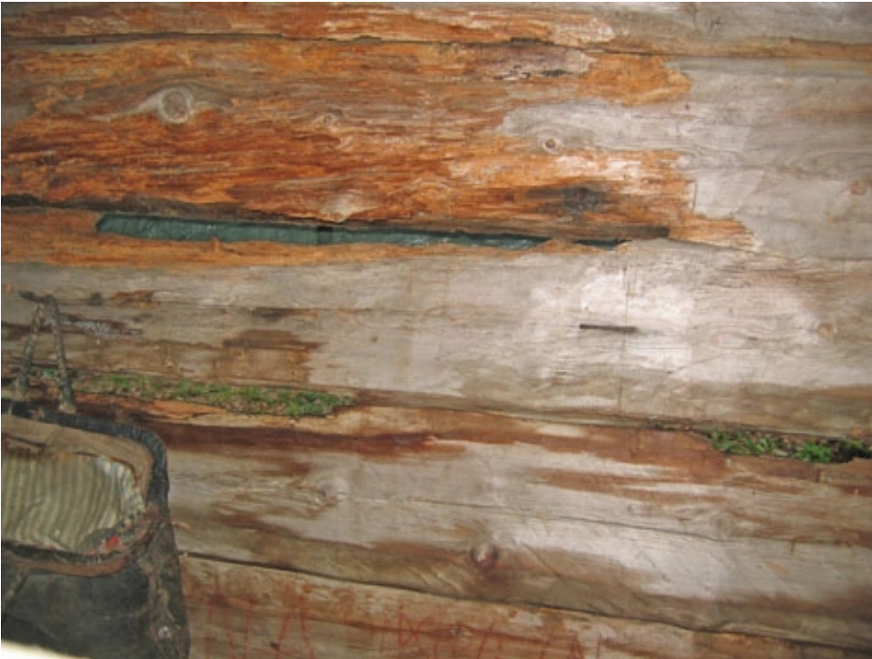
Hinkabölen luhtiaitan vaurioitunutta itäsivun hirsiseinää, kuvaus 2006-11-18 (PHo).
