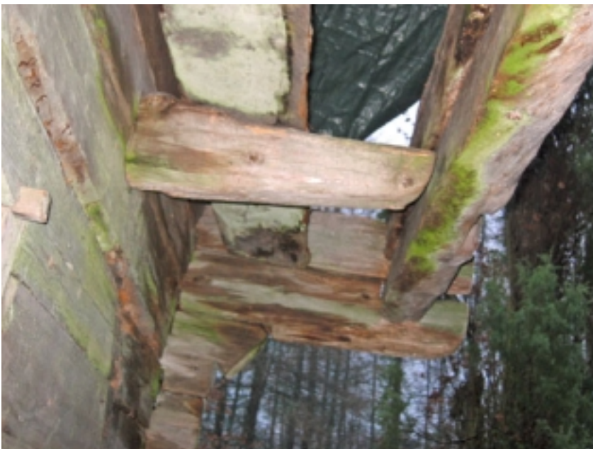
Hinkabölen luhtiaitta luhdin alta, jossa näkyy luhdin puuttuva lankutus sekä kosteusvauriot ( sammal, levä ja jäkälä ), kuvaus 2006-11-18 (PHo).
