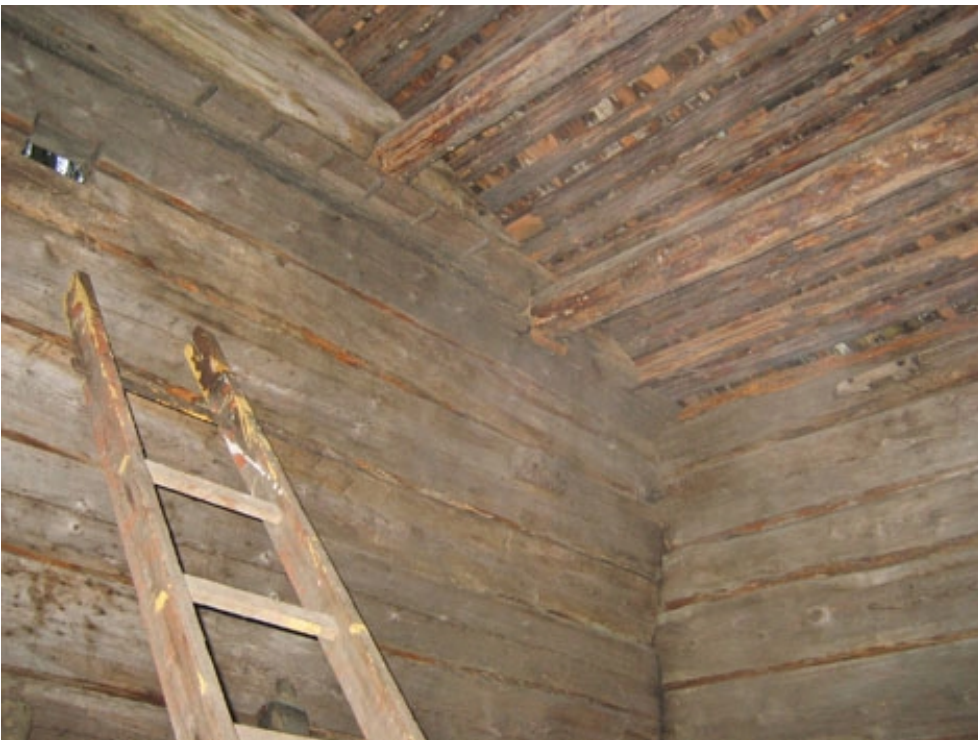
Hinkabölen luhtiaitan pohjoista päätyhirsiseinää sekä vesikattorakennetta, kuvaus 2006-11-18 (PHo).
