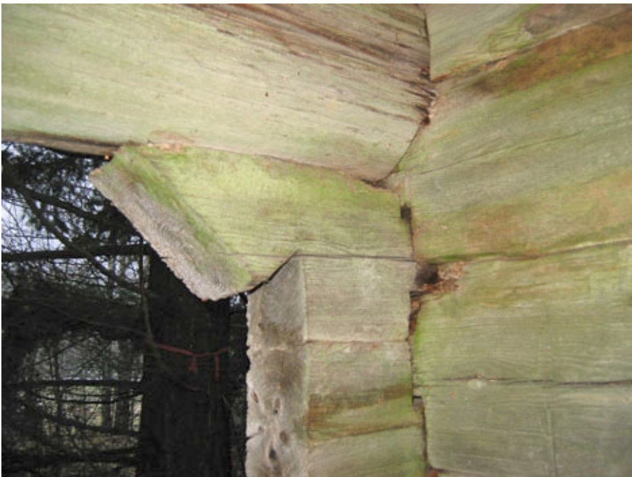
Hinkabölen luhtiaitta luhdin kannatuskonsooli, jossa näkyy itäsuomalainen veistomalli sekä salvoksessa lahovaurioita, kuvaus 2006-11-18 (PHo).
