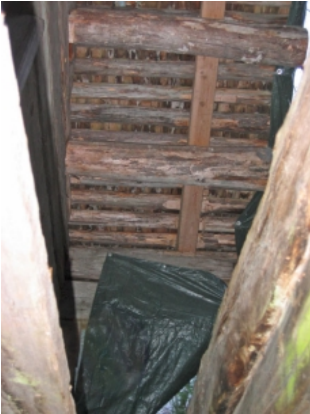
Hinkabölen luhtiaitta luhdin alta, jossa näkyy luhdin vesikatto ja tilapäiset alusrakenteet, kosteusvauriot ( sammal, levä ja jäkälä ), kuvaus 2006-11-18 (PHo).
