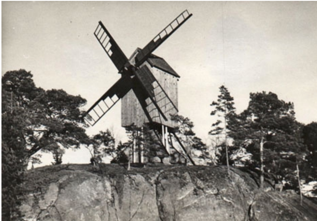
Hinkabölen tuulimylly katsottuna lounaasta Myllykallion juurelta keväällä 1953. Tässä kuvassa ovat vielä tallella siipilapojen tuulenohjaimet. Kuva: Mauno Sutela ( 8).
