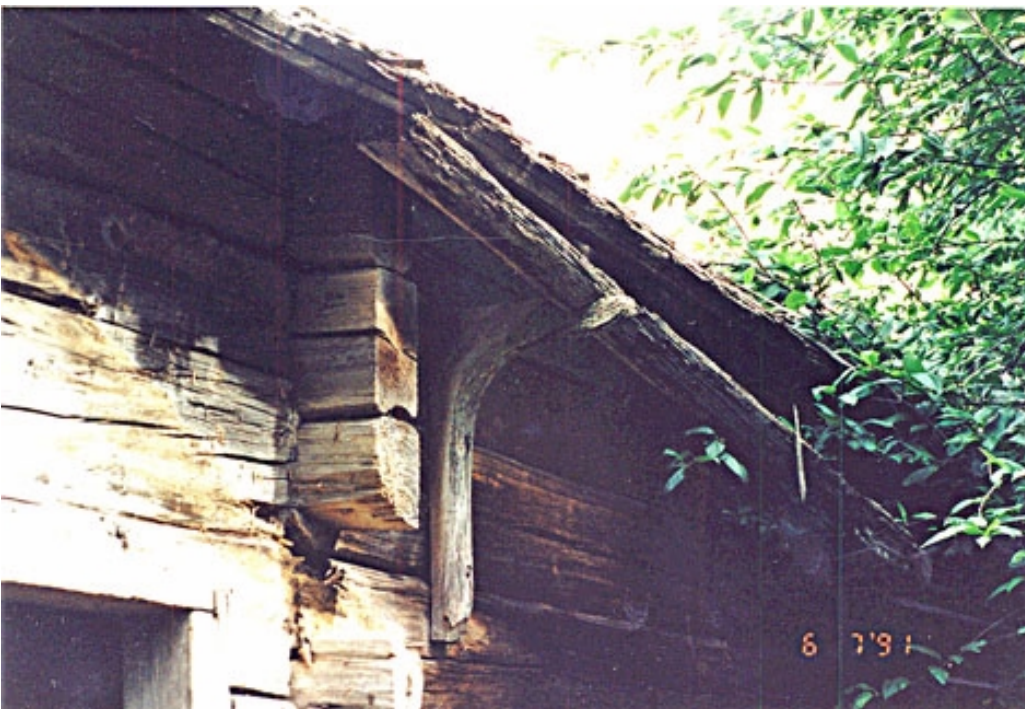
Hinkabölen tuparakennus, avokuistin purkupalokoot, kuvassa tuparakennuksen puurakenteinen vesikouru sekä kannatinkonsolit. Tänään jäljellä kannatinkonsolit, kuva 1991-07-06
