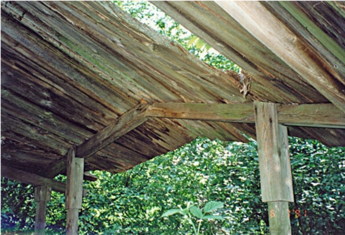
Hinkabölen tuparakennus, avokuistin purkupalokoot on aloitettu, vesikaton ulkoreunan purku, kuva 1991-07-06
