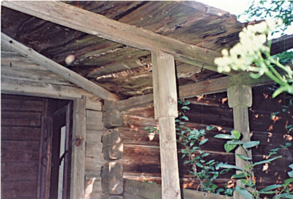
Hinkabölen tuparakennus, avokuistin purkotalokoot, vesikaton reuna ja kannatinpilarit koillisreunalla, kuva 1991-07-06
