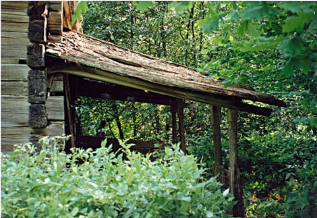
Hinkabölen tuparakennus, avokuisti ennen purkutalkoiden aloitusta, avokuisti lounaasta, kuva 1991-07-06
