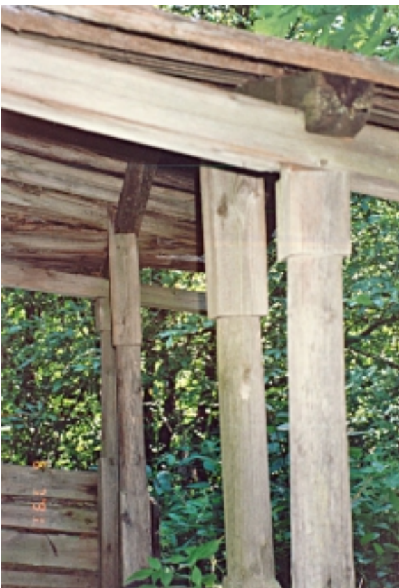
Hinkabölen tuparakennus, avokuistin purkotalokoot, kannatinpilarit avokuistin ulkoreunalla, kuva 1991-07-06
