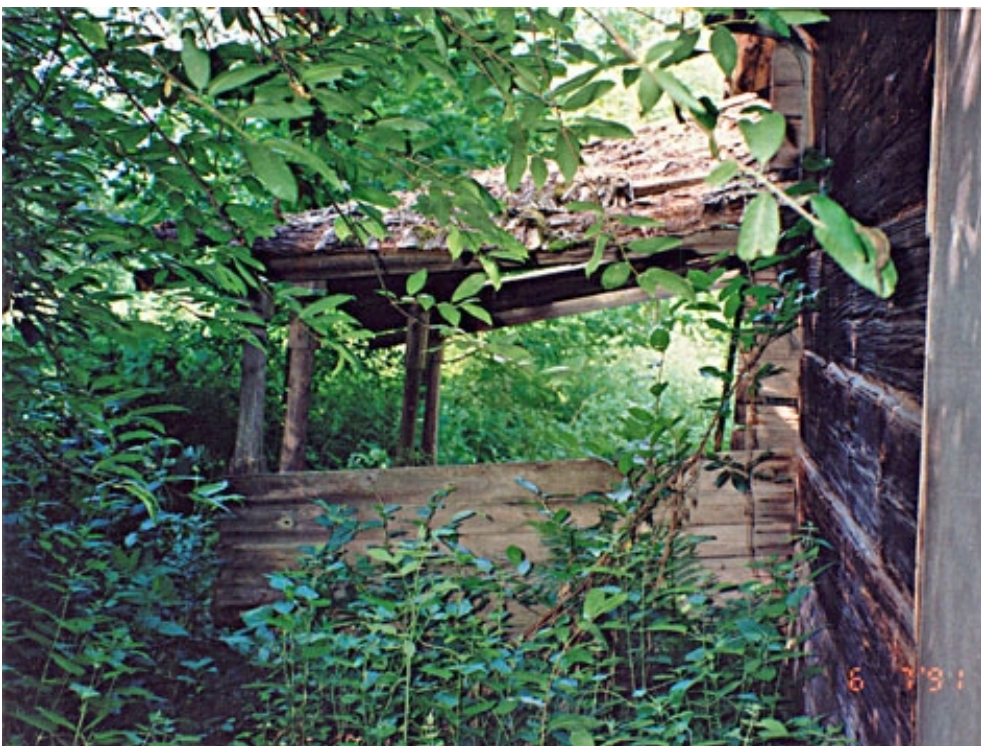
Hinkabölen tuparakennus, avokuisti ennen purkutalkoiden aloitusta, avokuisti koillisesta, kuva 1991-07-06
