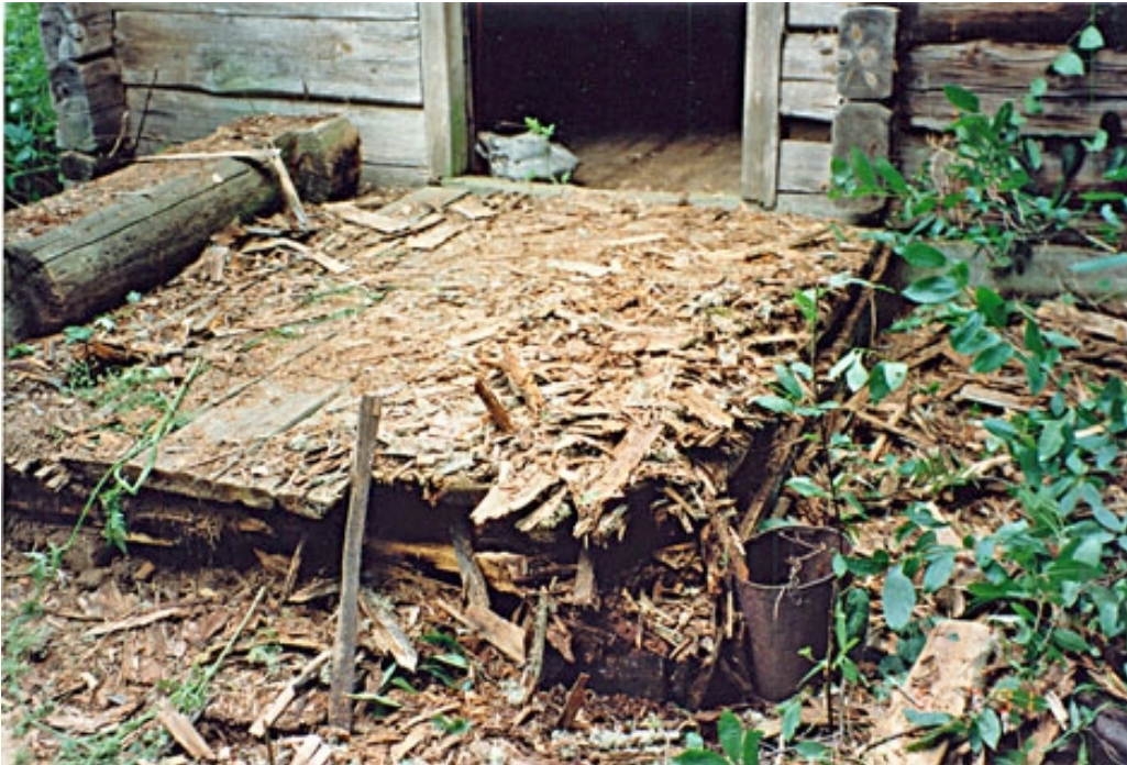
Hinkabölen tuparakennus, avokuistin purkupalokoot, kuistin lattiarakenne, kuva 1991-07-06
