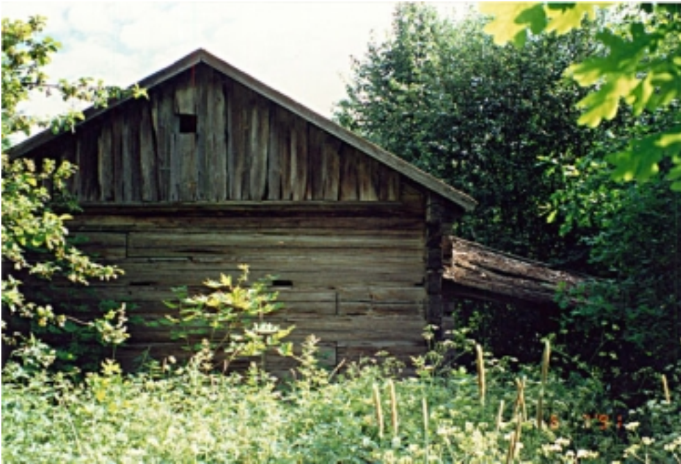
Hinkabölen tuparakennus, avokuisti ennen purkutalkoiden aloittamista, pääty lounaaseen, kuva 1991-07-06
