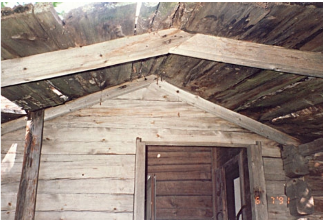
Hinkabölen tuparakennus, avokuistin purkupalokoot on aloitettu, vesikatto kuistilta alta, kuva 1991-07-06
