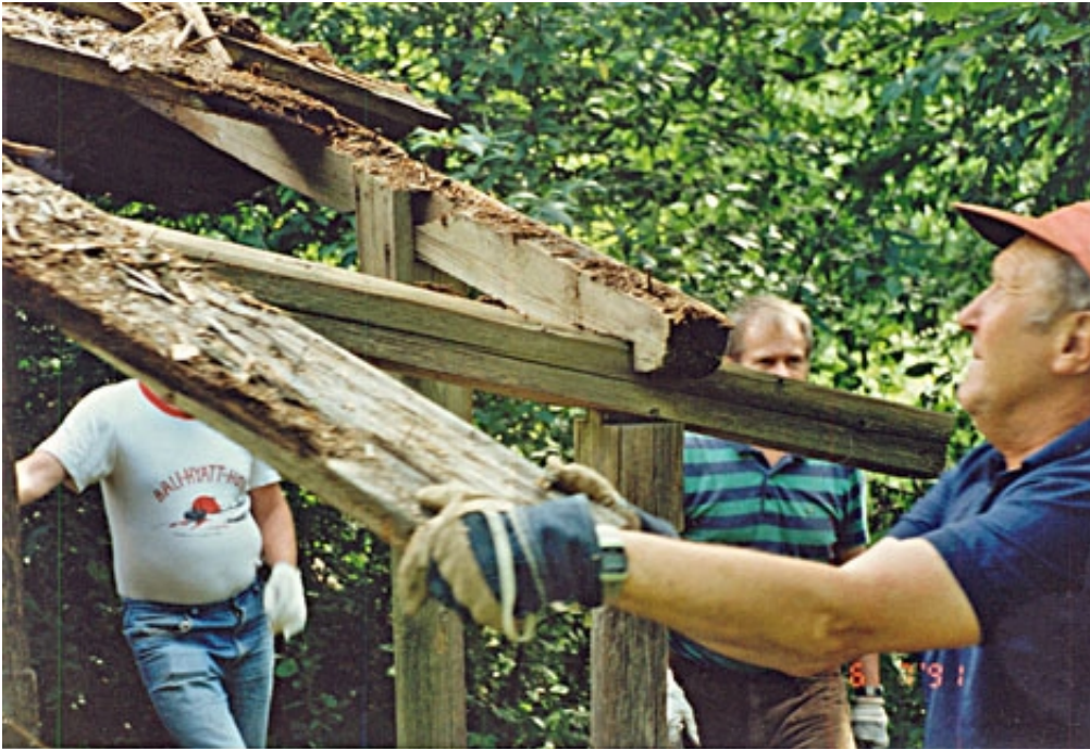
Hinkabölen tuparakennus, avokuistin purkupalokot, selkäpuun ja vesikaton purku, kuva 1991-07-06
