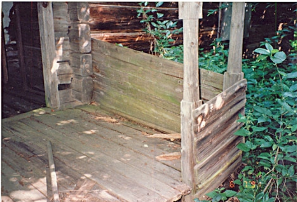
Hinkabölen tuparakennus, avokuistin purkupalokot, kuistin suojaseinä kaakkoon ja koilliseen sekä kuistin lattialankusto, kuva 1991-07-06
